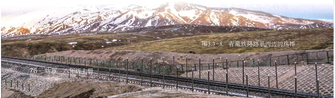
图3.3-8 青藏铁路路基两边的热棒
